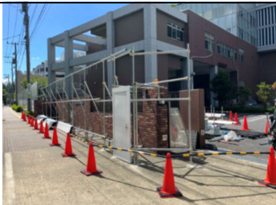
仮囲い設置中
