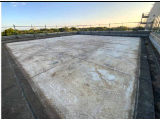
屋上樹木撤去
