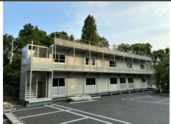
仮設事務所設置中
